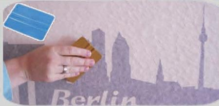
• Nun streichen Sie mit einem Raker oder einer gleichwertigen Andrückhilfe das gesamte Wandtattoo gleichmäßig auf die Oberfläche. Vermeiden Sie, dass hierbei Falten und Blasen entstehen.
